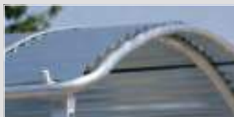
Borde de protección en todo el perímetro del tejado
